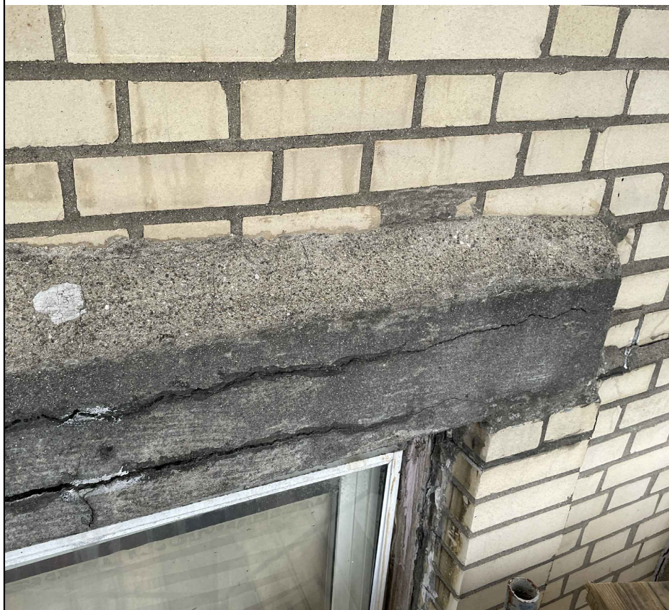
4 EXISTING LINTEL SCALE: N.T.S.
